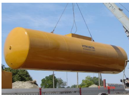
РЕЗЕРВУАР СТАЛЬНОЙ ДВУХСТЕННЫЙ ДЛЯ ХРАНЕНИЯ СВЕТЛЫХ НЕФТЕПРОДУКТОВ
